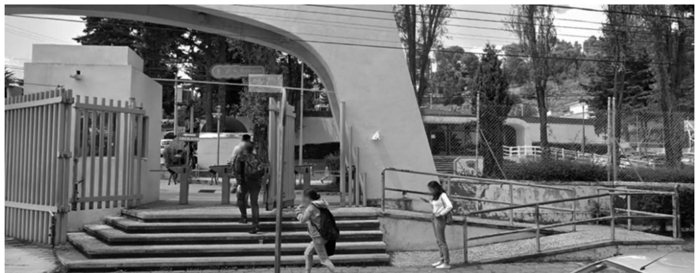
Imagen 5. Acceso peatonal de la Facultad de Arquitectura y Diseño. Fuente: Facebook (27 de julio, 2020) https://www.facebook.com/UAEMex/photos/a.10152391243171005/10152391243861005
