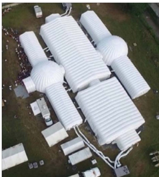
Figura 6. México: El hospital neumático para atender a pacientes con COVID-19. Fuente: Tecnodimensión en Sota, 2020.
