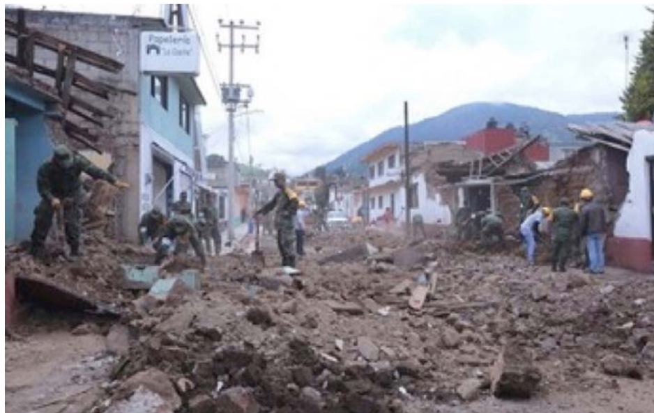
Figura 3. Municipio de Joquicingo después del sismo, gran cantidad de construcciones civiles de adobe resultaron como pérdida total. Fotografía: Elda Gómez Rogel.
