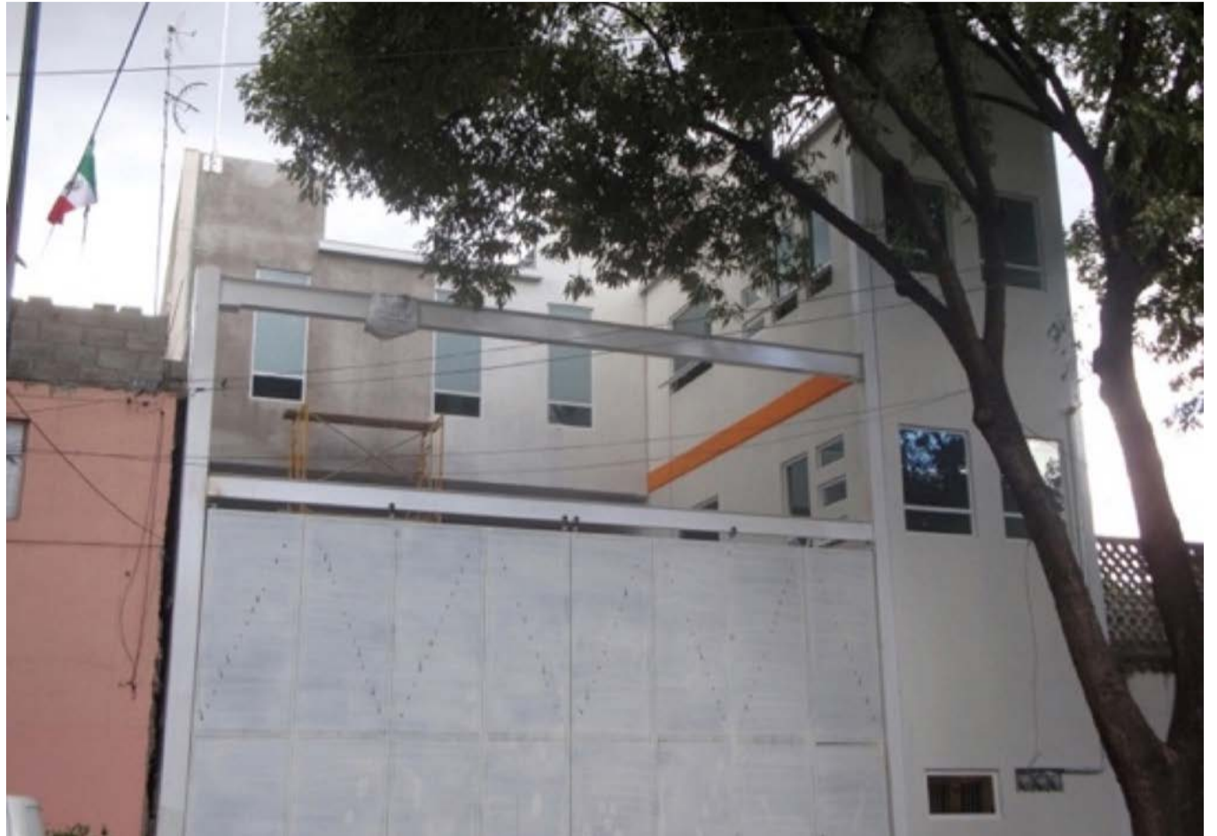
Figura 3. Viga de refuerzo estructural en fachada
