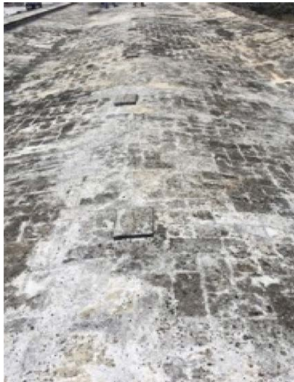
Fig. 10. Bóveda con grieta transversal en el Centro Cultural en su vista exterior. Se localiza sobre el archivo y biblioteca. Fotografía: Eizi Rodríguez Velázquez.
