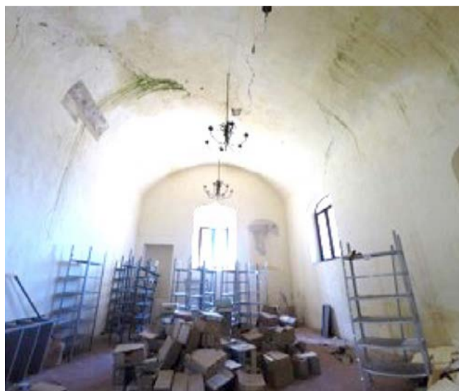
Figuras 7 y 8. Interior del archivo municipal. Muestra de la presencia de grietas y humedades.
